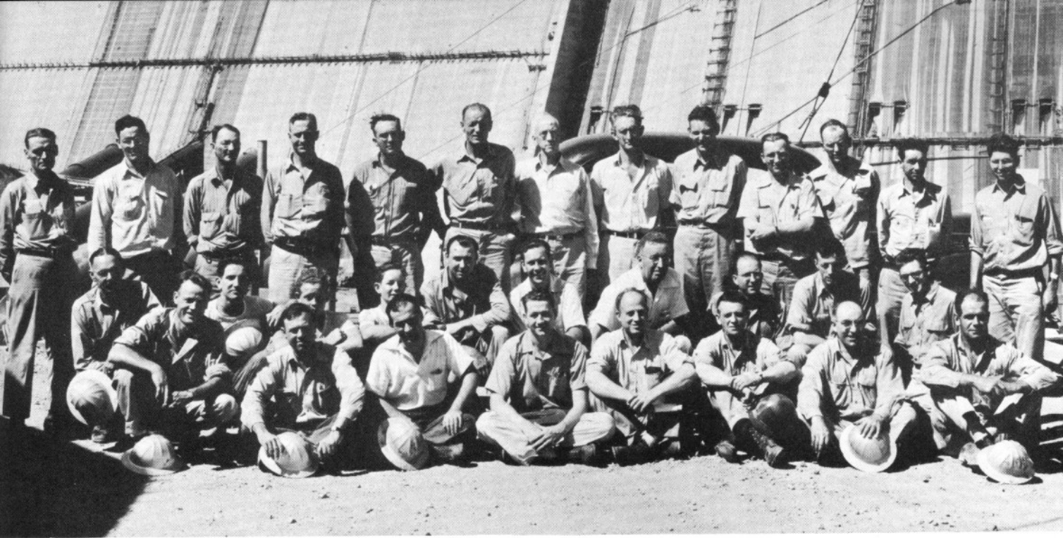
U. S. B. R. Inspectors
